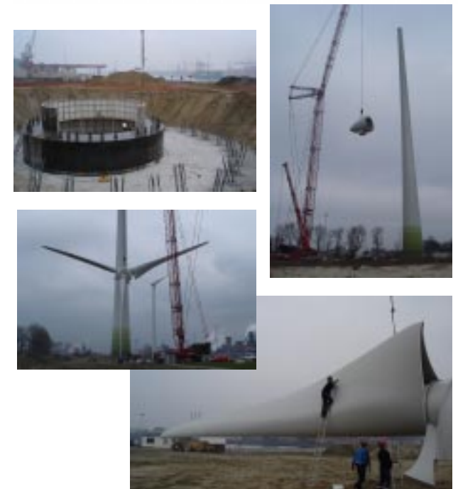
De opbouw van een windturbine gaat vrij snel - het langste duurt de aanleg van de fundering.
